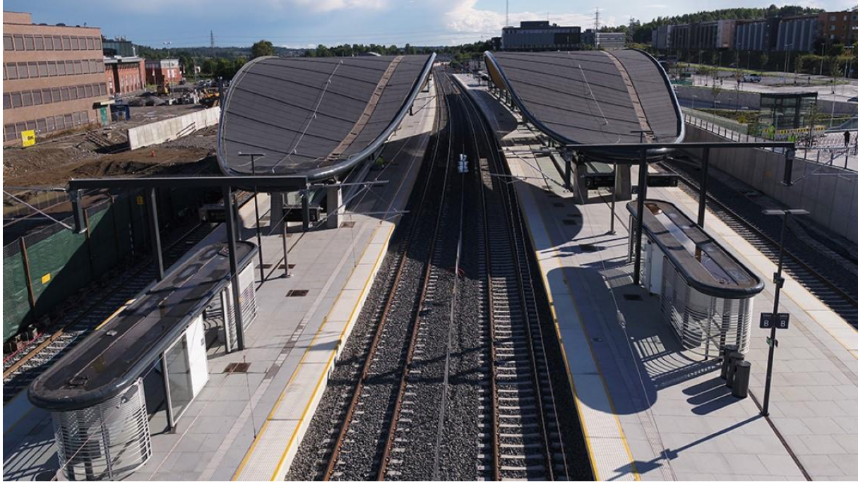
Foto: Bane Nor - Røer Production – Nye Ski stasjon
