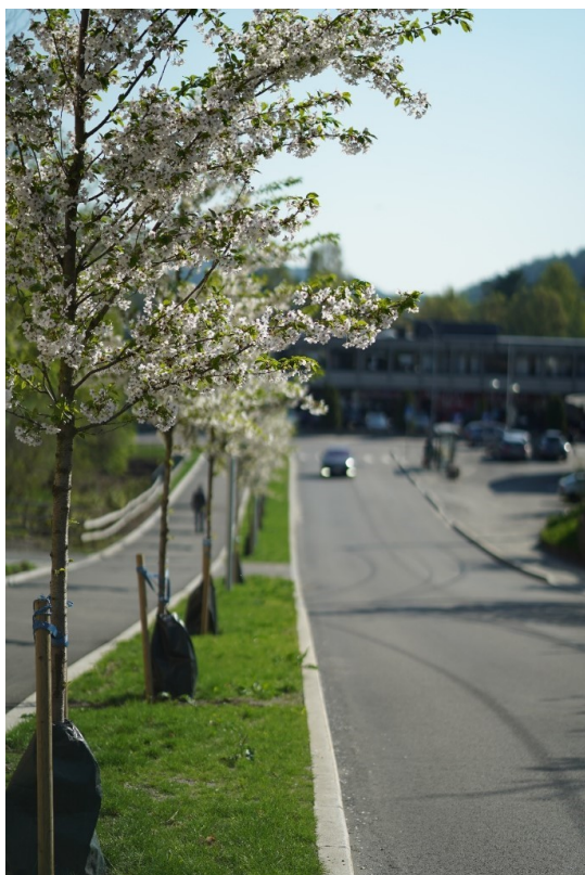
Bilde fra veianlegget i Ormerudveien.
