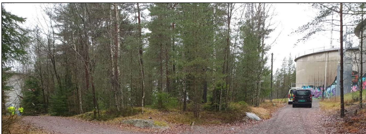
Figur 6.1.2 To høydebasseng til høyre tilhørende Nordre Follo kommune, ett til venstre tilhørende Ås kommune
