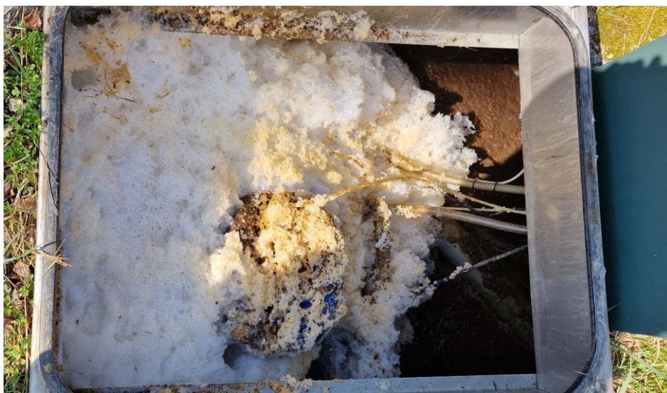
Bilde 5. Odin anlegg (Nordre Follo kommune, 2023)
