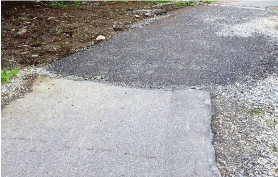
Figur 7: Eksempel på midlertidig istandsetting
